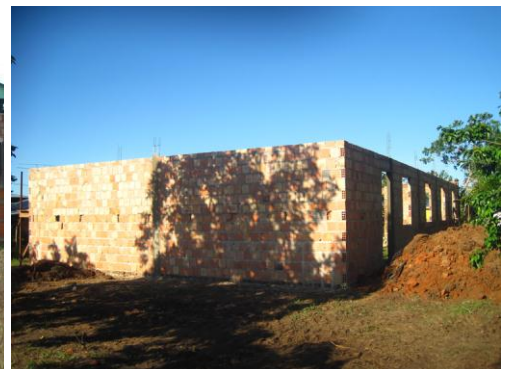
Ready to pour the concrete “belt”
