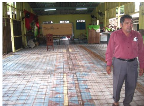
Presidente Figueiredo Construction - Moises
